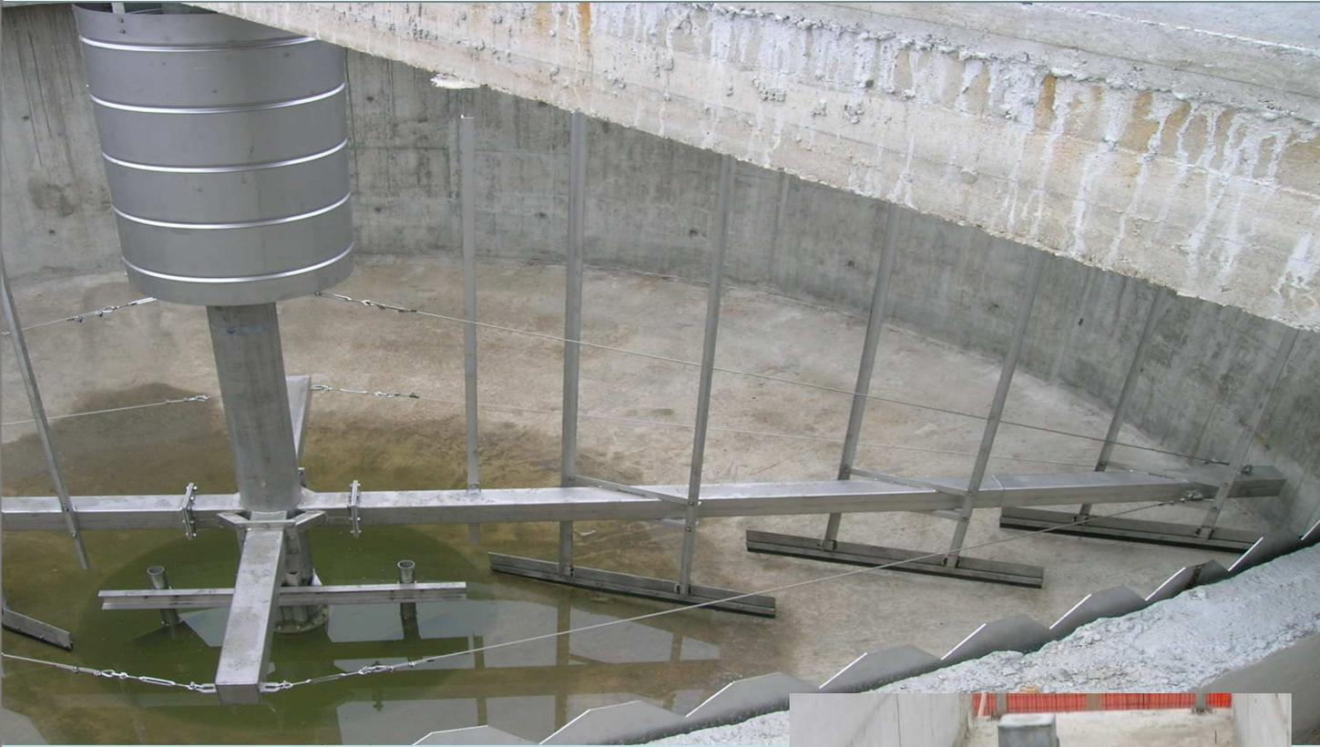
L'ispessimento o addensamento è in genere la prima fase a cui vengono sottoposti i fanghi, provenienti dai cicli di depurazione delle acque, che ha lo scopo di ridurre l'umidità presente nei fanghi stessi.
